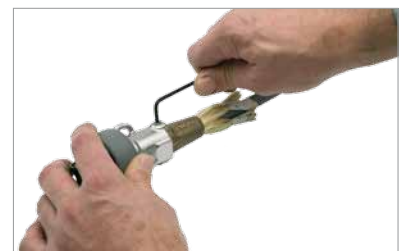
Montage der Verbindung auf das untere Lager bzw. den Fallwirbel.
